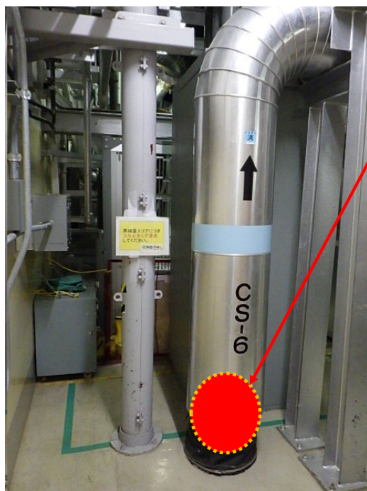
図12 既知の線源位置（CS配管において線源と見られる位置）
